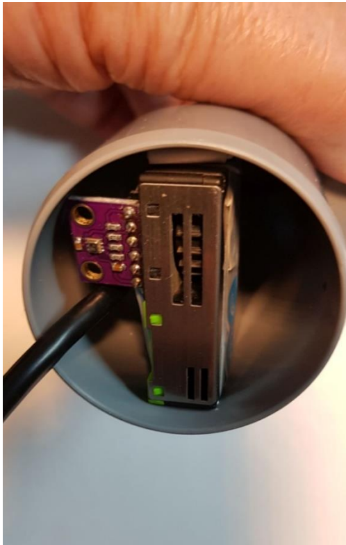
Abbildung 75 Montage SPS30 am Ende des HT DN50 Bogens
