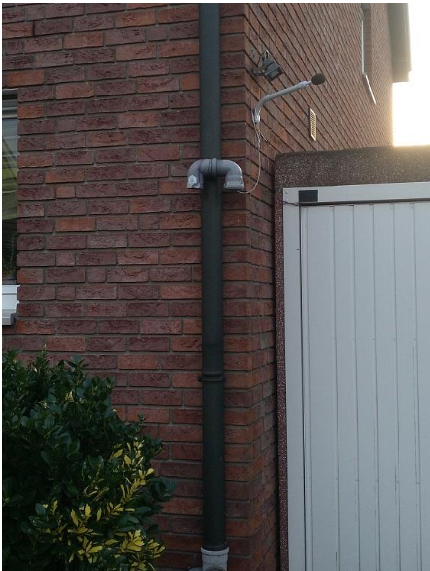
Abbildung 88 Mikrofon Anbringung Beispiel 4
